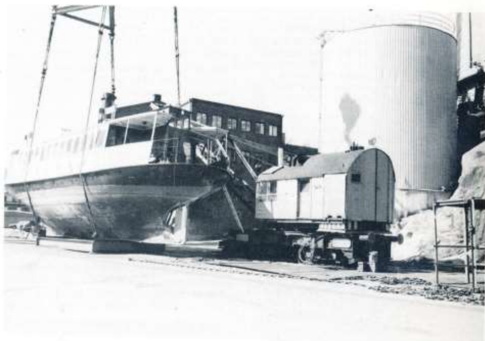
FÄRJAN 4 på Sörhallskajen vid Eriksberg. Varvet skall utföra skrovarbeten på färjan innan den kan tagas trafik i början av juni. Intill färjan står Götaverkens sista kvarvarande ångkran som skall ingå i det planerade varvsmuseet på Eriksberg. Foto Kennet Magnusson 13 april 1981.
